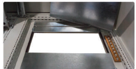
Nowy system podparcia płyty montażowej
